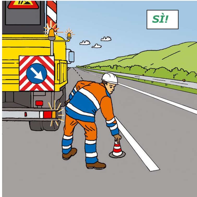
Figura 58 – Posizionamento dei coni o defleco: comportamento corretto
