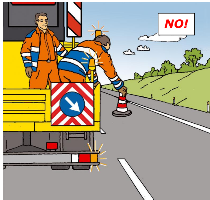
Figura 59 – Posizionamento dei coni o defleco: comportamento scorretto
