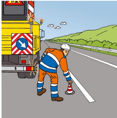
Figura 43 – Chiusura della corsia di sorpasso: inizio della posa dei coni
