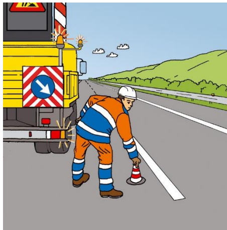
Figura 56 – Chiusura della corsia di sorpasso: inizio della posa dei coni
